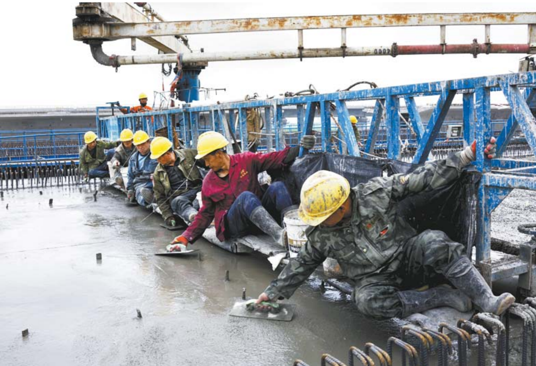
步调一致，工人们在对浇筑混凝土的桥面进行作业。
