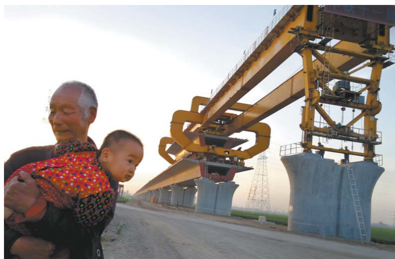
一位村民抱着孙子看高铁大桥施工。济青高铁建设将造福子孙后代。
