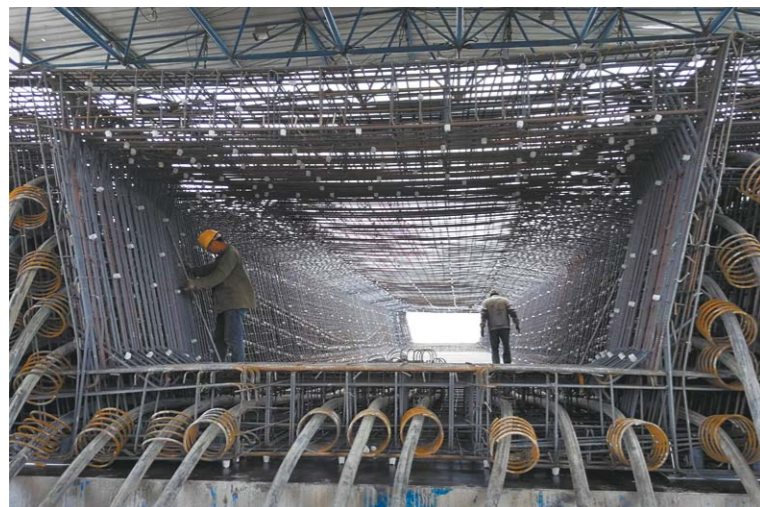
工人对绑扎入模的钢筋进行巡检。
