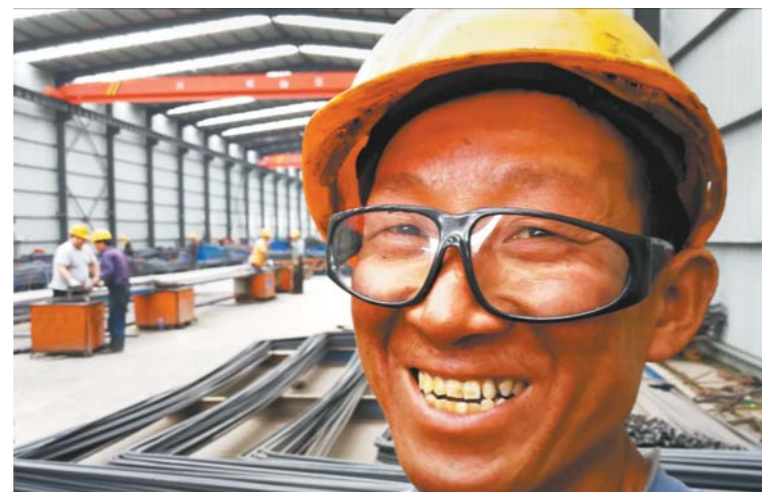
41岁的湖北人陈敬安负责钢筋的定位加工，他来工地已整整一年。
