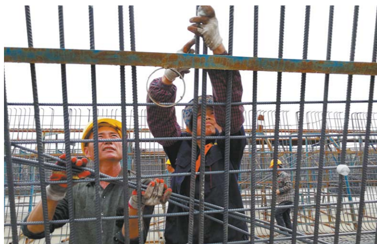
工人正在进行钢筋捆扎作业。
