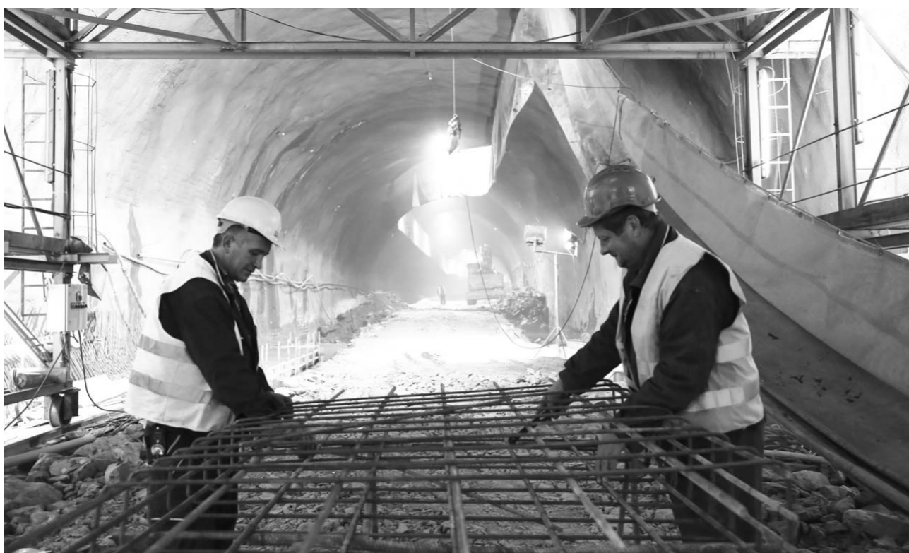
两名塞尔维亚工人在塞尔维亚E763高速公路第五标段隧道内绑扎钢筋。该段高速公路由中国山东高速集团承建。塞尔维亚E763高速公路建成后大大缩短首都贝尔格莱德至相邻国家及出海口的通行时间，促进当地经济发展。
