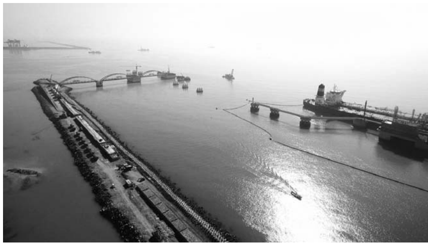
日照港岚山港区30万吨级原油码头二期工程施工现场。
