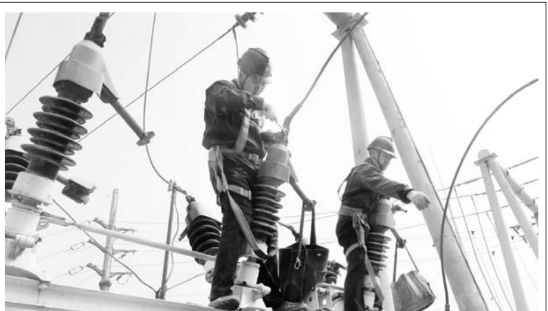
近日,国网东平供电公司变电检修人员按照春检计划,合理安排停电时间,对110千伏银山变电站35千伏戴庙II线312-2刀闸进行更换,确保东平湖西地区供电安全稳定,为迎峰度夏打下坚实基础。(孟广勇)
