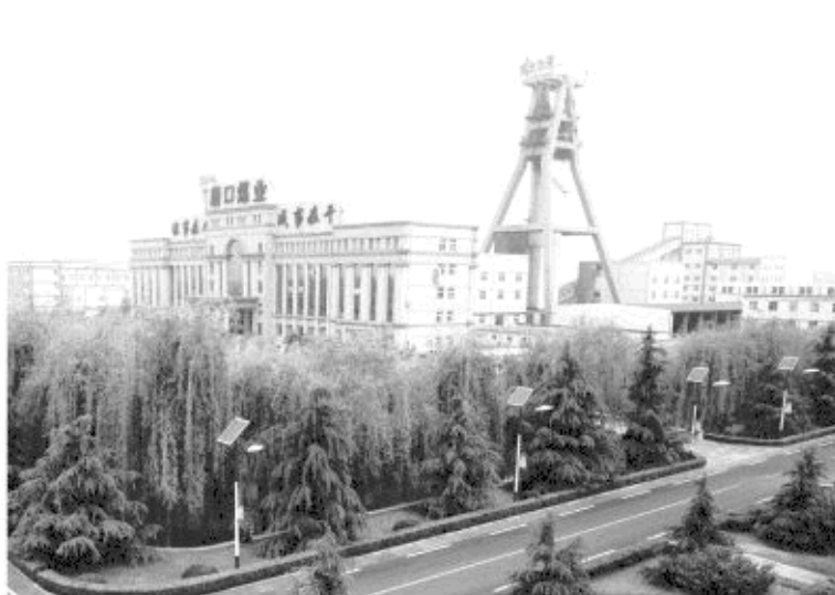
△淄矿集团唐口煤业
