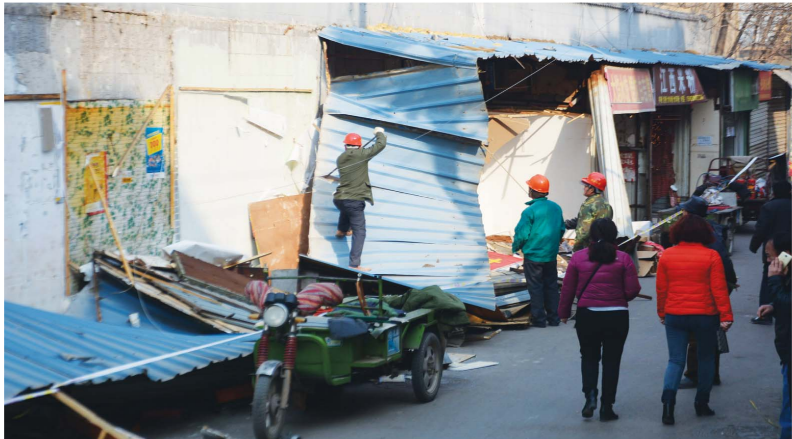
位于槐荫区纬十一路的违建板房被拆除。
