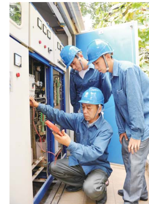
△电力人员巡视检查用户设备
