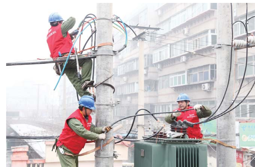
△供电员工为老旧小区更换变压器 □高立联 报道
