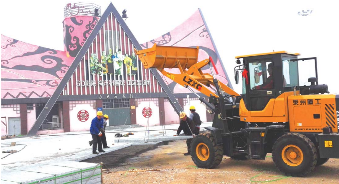
2月13日,潍坊滨海风筝冲浪基地改造提升项目正在紧张施工中。此次改造和提升主要针对中心广场活动区,对原有马来西亚馆餐饮街、游客服务中心户外休闲区、演艺舞台、停车场、沙滩游乐广场进行提升,以体现生态、绿色的园林效果,打造滨海旅游新景观。图为潍坊滨海风筝冲浪基地改造提升项目现场。
