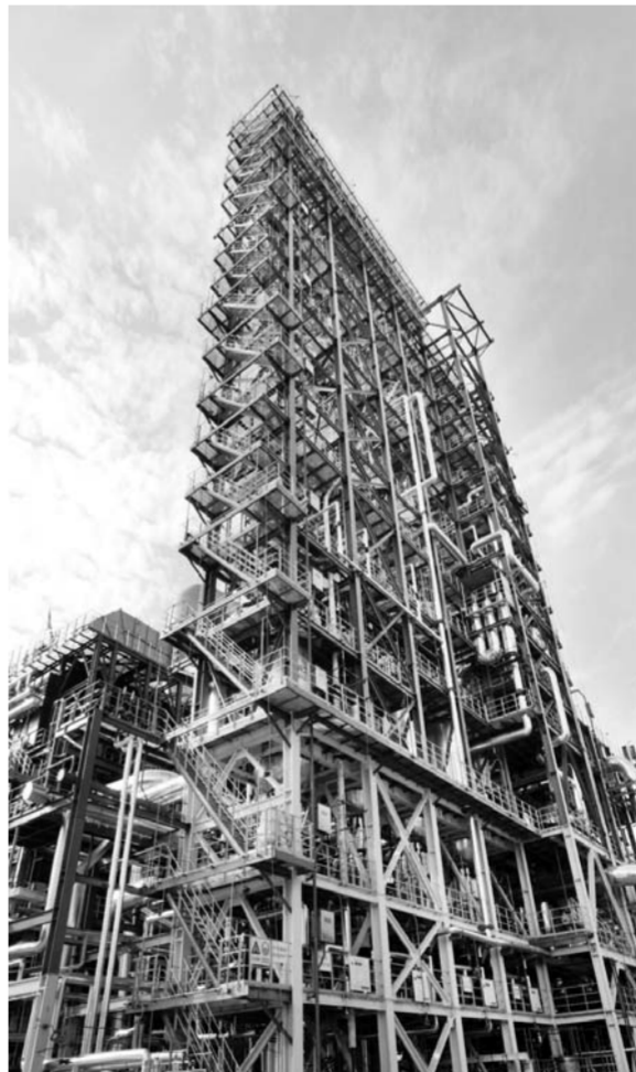
△世界首套逆流移动床连续重整装置
