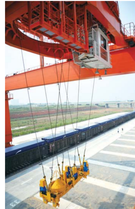
△青岛多式联运海关监管中心大型龙门吊作业现场
