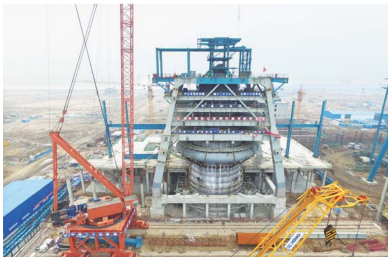
△建设中的山钢日照钢铁精品基地
