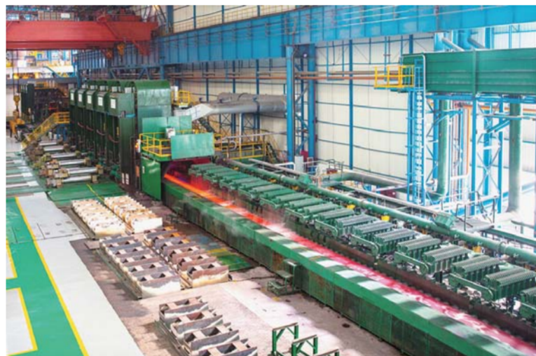
△日照钢铁ESP生产线
