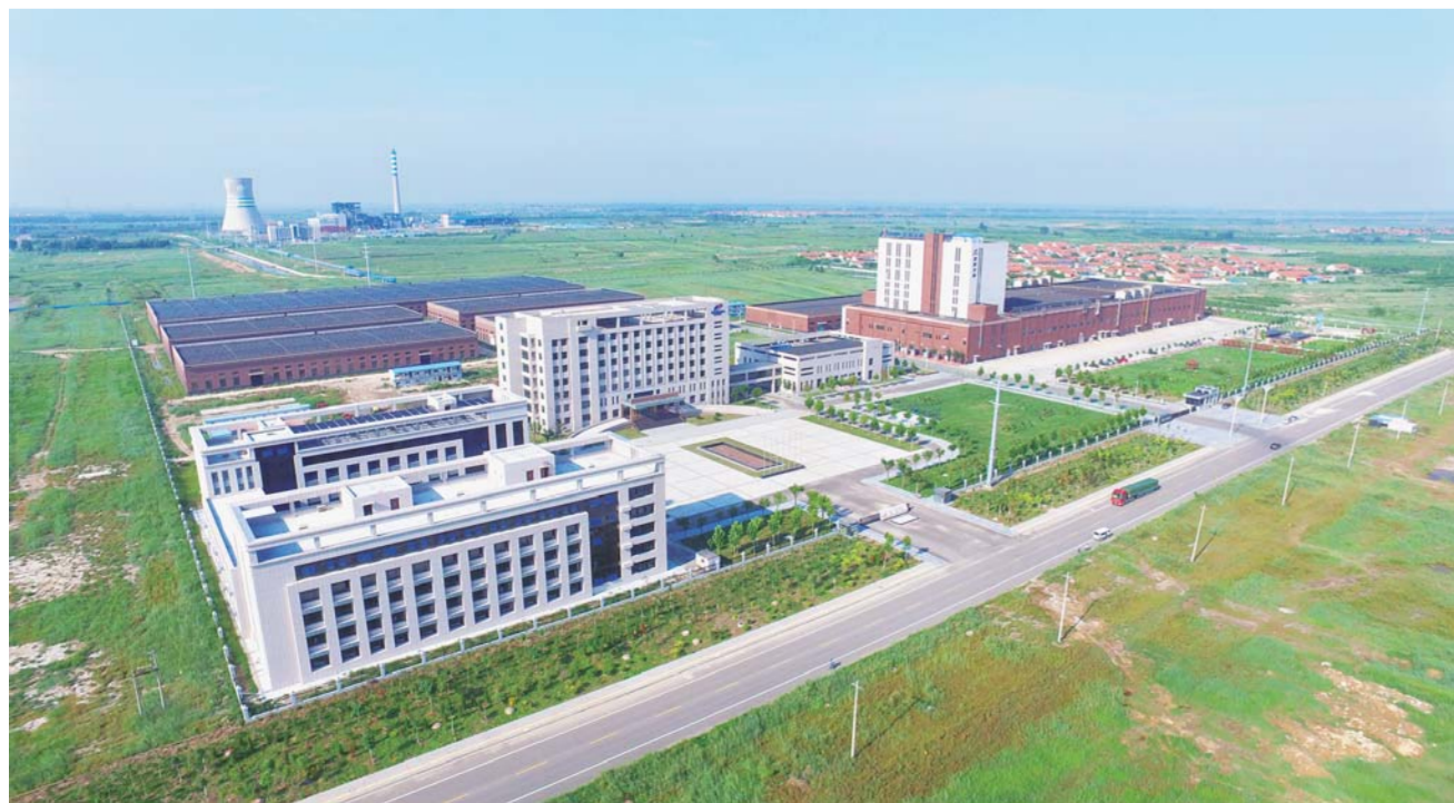
△胜通光学膜材料科技有限公司航拍图
