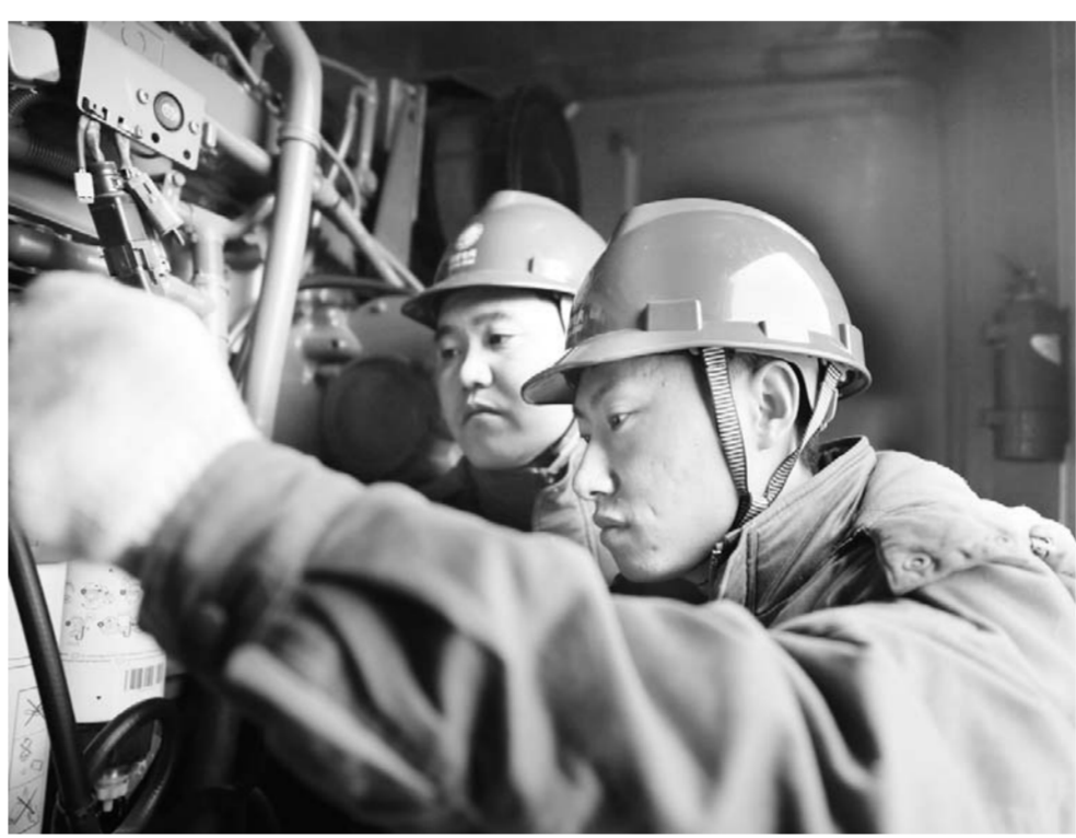
2月4日，国网莱芜供电公司圆满完成了莱芜市2017年全市总结表彰大会的电力保障工作。此次，莱芜供电公司启动了“双电源、末端快速自切、UPS、自备电源”4层保障机制，全力做好保电工作。（王宪才 左丰岐）
