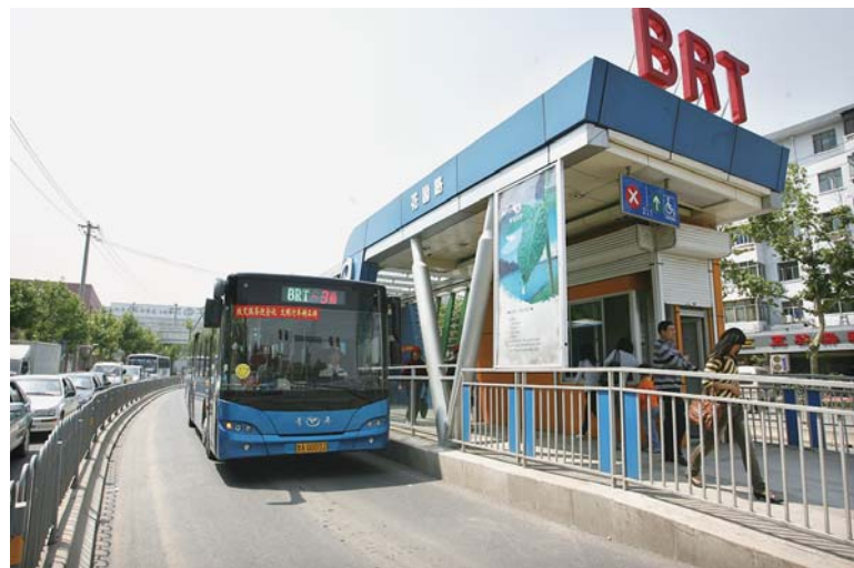
△2008年4月以来，济南先后开通运行7条BRT线路，形成“两横三纵”快速公交网络，成为全国首个实现快速公交独立成网的城市。
