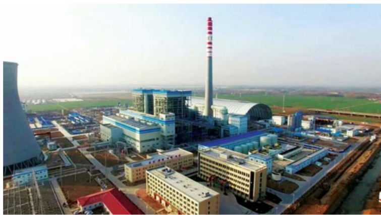
△大唐临清热电联产项目竣工投产
