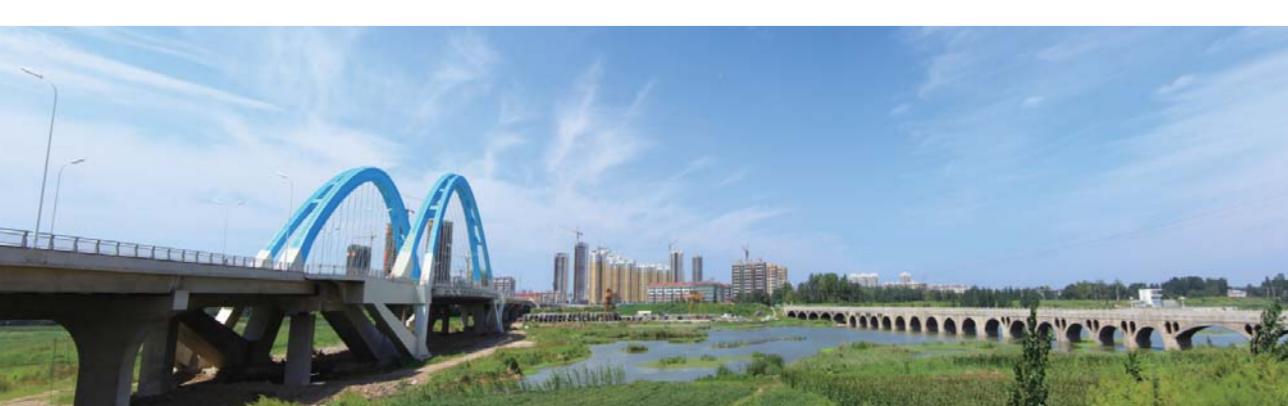
△泗河兴隆大桥
