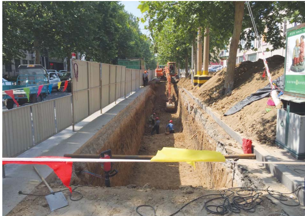
施工单位正在铺设地下管网(资料片)。
