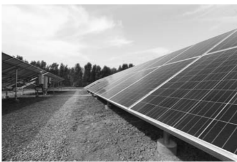
□通讯员 马志鹏 报道 2016年10月,商河县玉皇庙镇开家村扶贫光伏电站并网发电。
