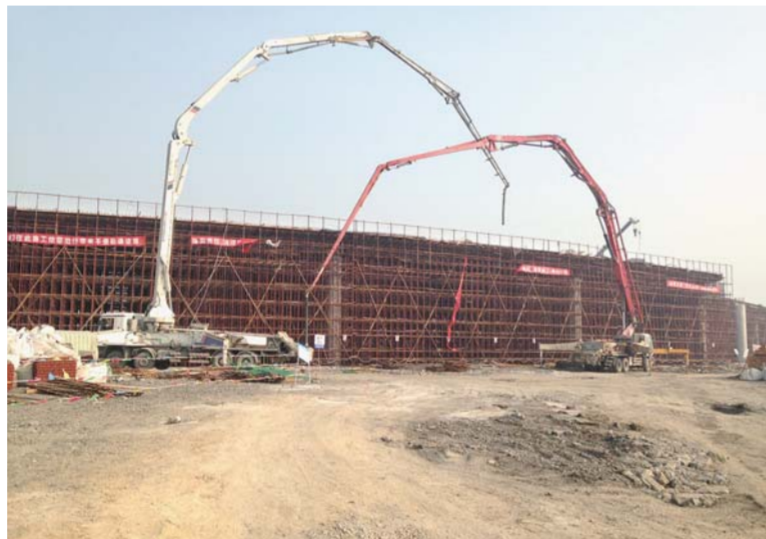
△济宁枢纽互通现浇梁浇筑
