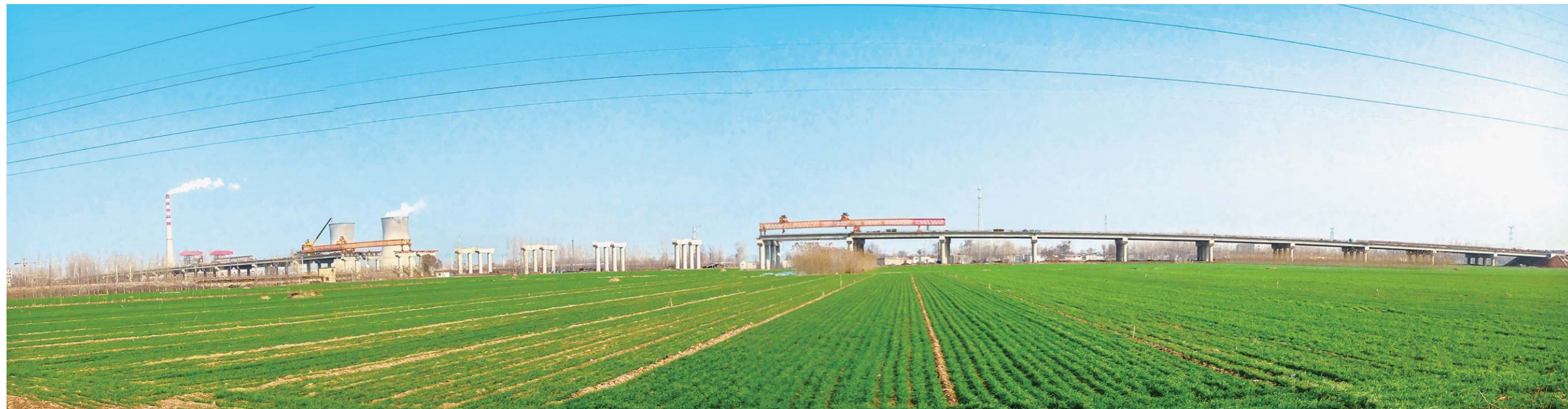
△公铁立交箱梁架设
