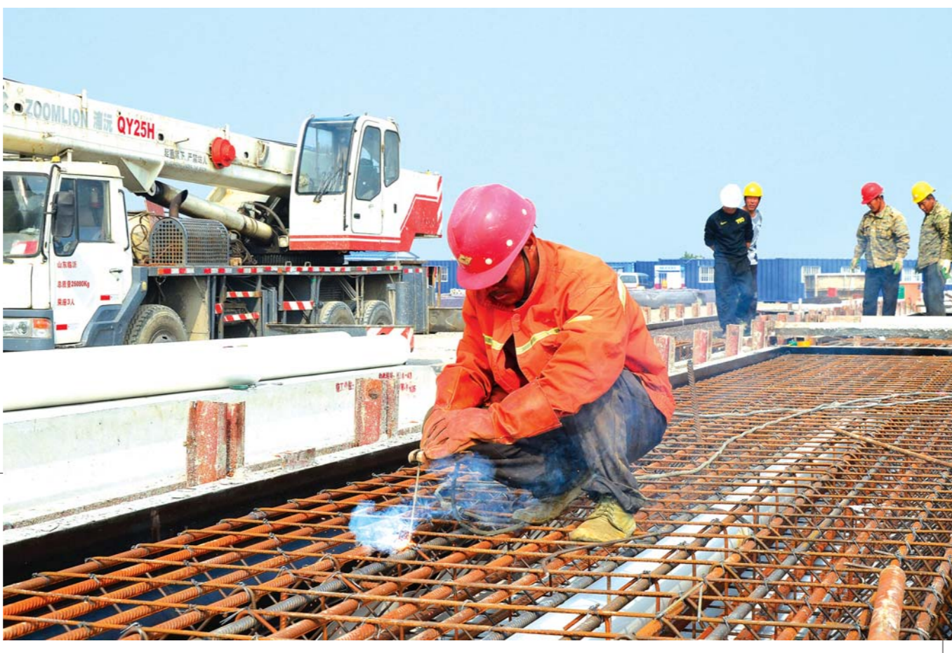
滨海区欢乐海国际游艇码头项目正在稳步推进,该项目总投资约8.9亿元,建筑面积达3.4万平方米,将建设741个泊位,打造黄河三角洲地区最具吸引力的滨海旅游名片。图为滨海区欢乐海国际游艇码头项目建设现场,工人正在进行钢筋绑扎。
