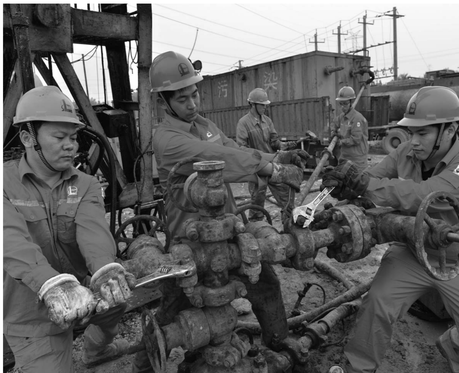
胜利油田采油厂井下作业大队，正为采油管理七区新投的三胞胎井组STS3RP30井，作酸洗、氮气返排作业施工的前期准备。(资料片)
