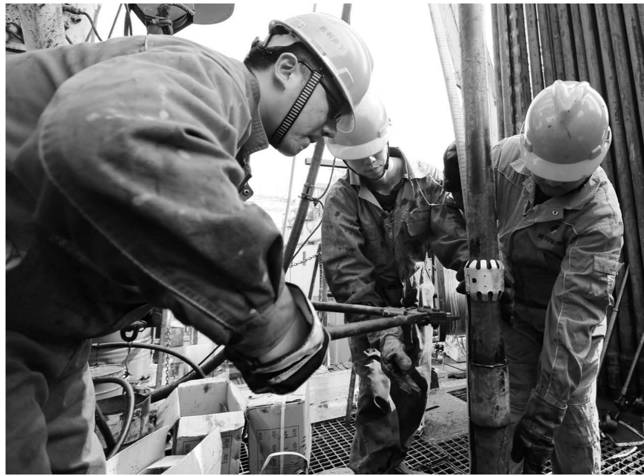
□张海彬 报道 胜利海洋采油厂员工在采修一体化平台上施工。
