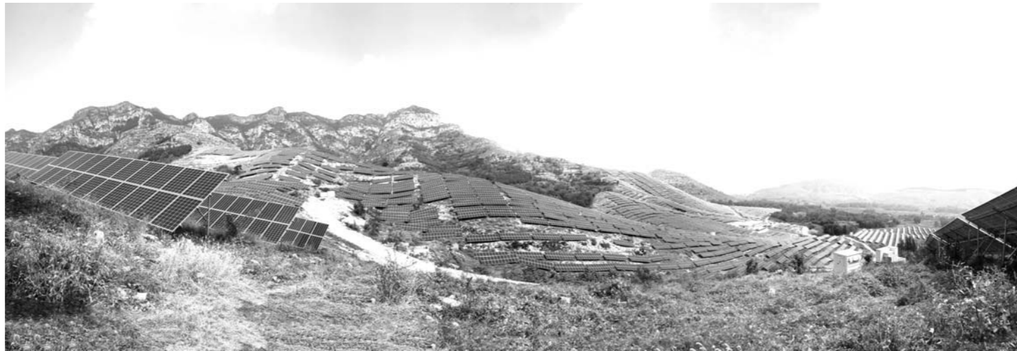
华能淄博博山光伏发电有限公司的光伏发电项目。
