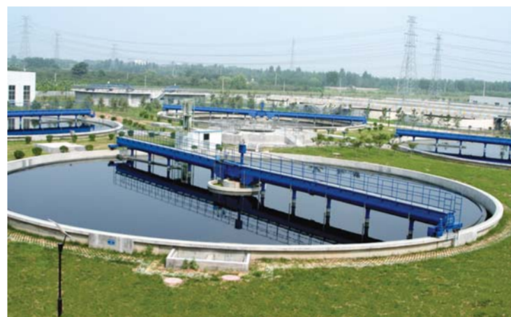
△大力支持节能环保。图为泰安市第二污水处理厂
