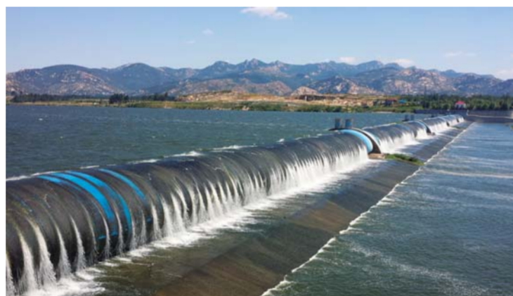
△大力支持重点工程建设。图为大汶河颜坝工程
