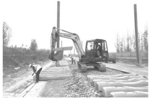
青连铁路日照段正在紧张施工当中。
