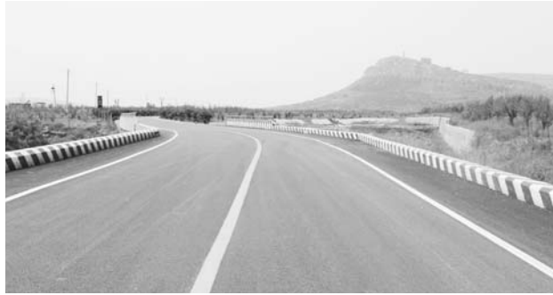
△安全生命防护工程让农村公路更安全
