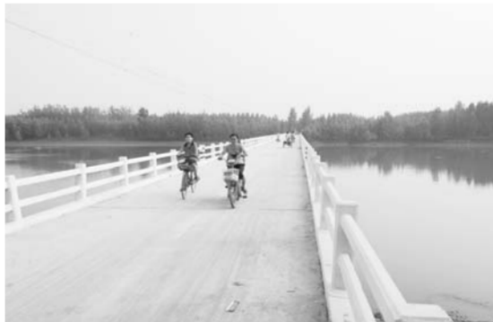
△安防设施齐全的通村路桥
