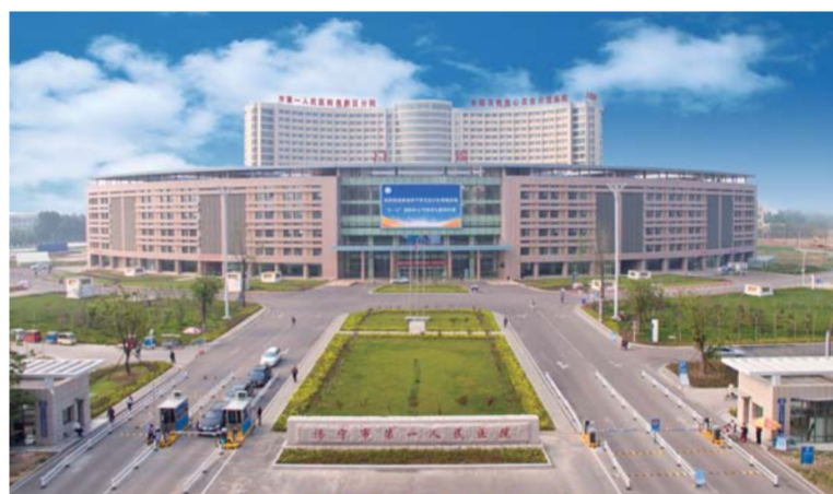
△医院东院区实景图
