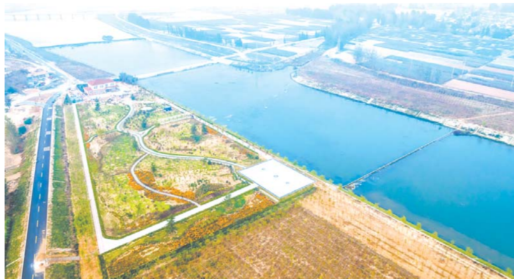
图为东港区陈疃河治理工程。(资料图)
