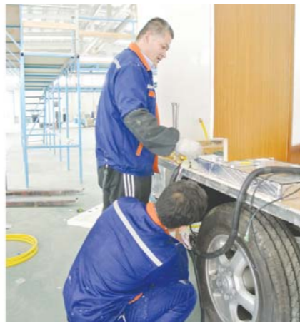
图为“春田”房车车间工人正在安装房车卫生间下水管路。
