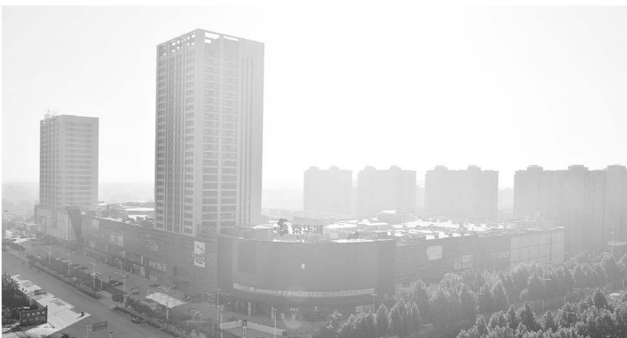
11月3日，青州市街头建筑笼罩在雾霾中。
