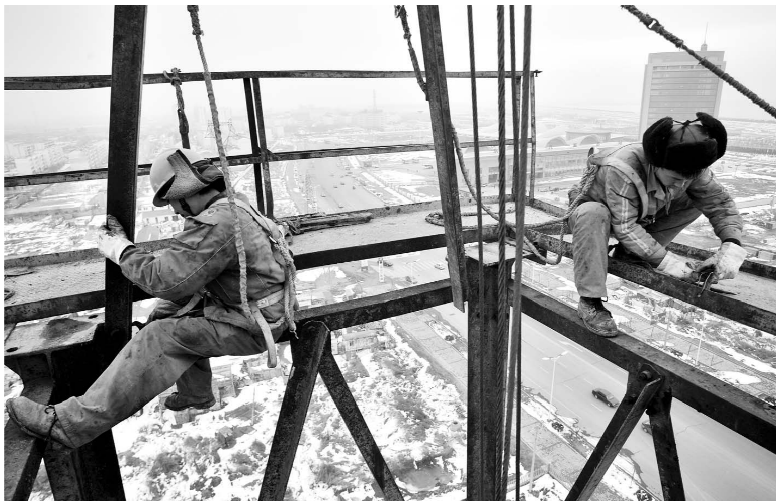
将841块角铁、1774颗螺丝搭成45米高的铁塔，构成了井架安装四队工作的全部。(资料片)
