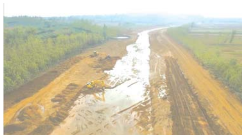
正在施工当中的巨峰河二期治理工程。
