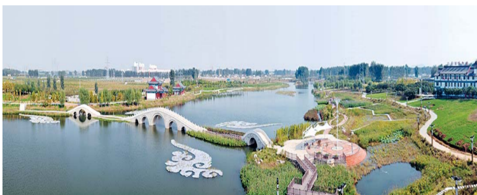
△曲阜市蓼河人工湿地生态修复和水质净化工程
