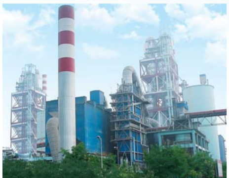
△曲阜中联水泥余热发电工程
