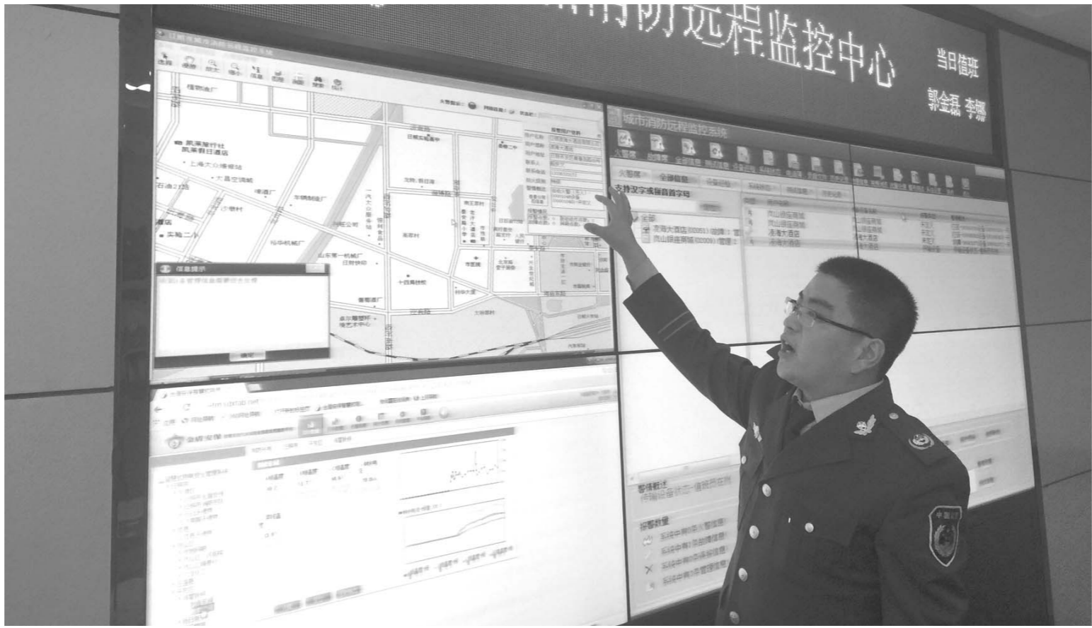
山东省金盾消防安保服务有限公司日照分公司工作人员向记者介绍城市消防远程监控系统。
