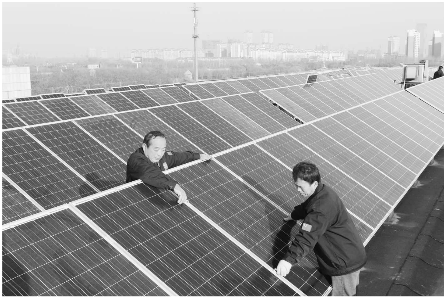
金秋10月，寿光羊口镇的工人们正在安装光伏太阳能发电板。太阳能发电，正在成为羊口的清洁能源。
