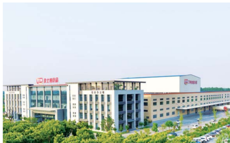
△山东诸城佳士博公司新建的多层立体智能冷库
