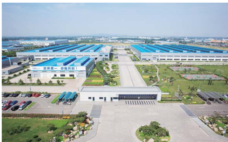
△开发区汽车产业园派沃泰变速箱项目航拍图
