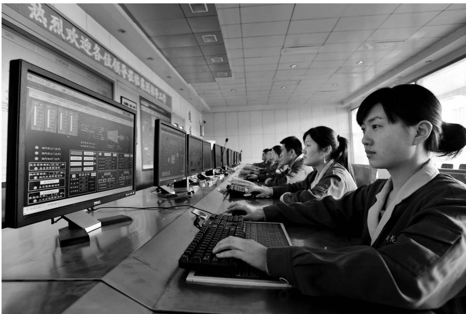
新龙集团员工在中控室电脑屏幕上即可了解厂区设备运转情况。
