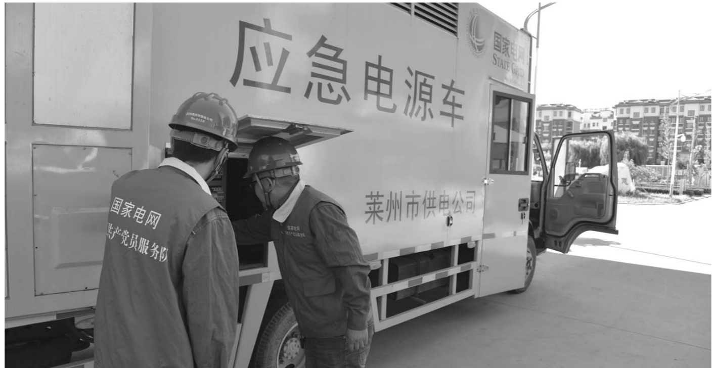
8月30日,国网莱州市供电公司制订周密方案,组织专业人员对烟台市委、市政府在莱州市开展2016年全市民生项目观摩活动现场进行线路设备巡视检查,确保了观摩活动期间安全可靠用电。
