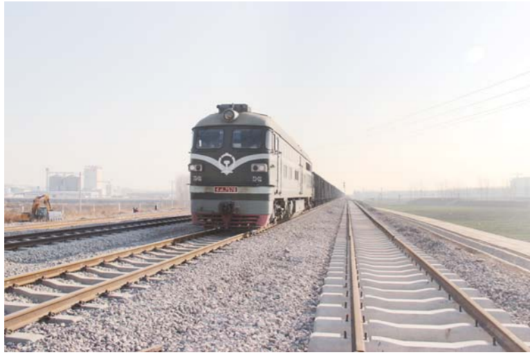
△广饶物流园铁路专用线
