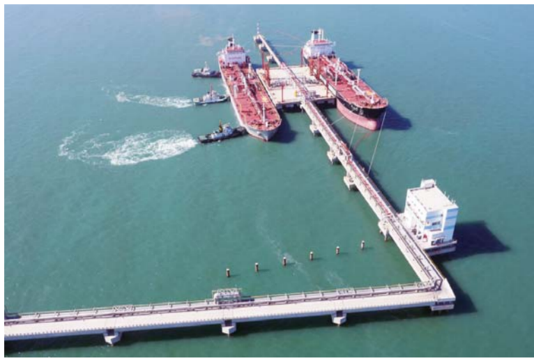
△东营港2个5万吨级原油码头正在卸油
