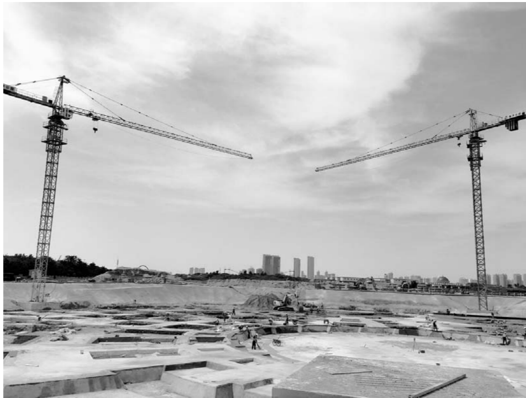
正在施工的日照海洋公园建设现场。
