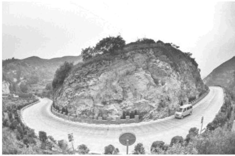
△莱芜市泰安舒山区公路
