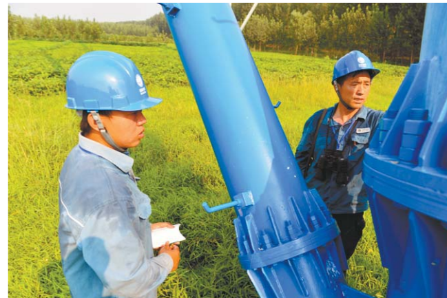
铁塔每一个螺丝的松动或丢失，安民玖和刘方鹏都会仔细检查、记录。
