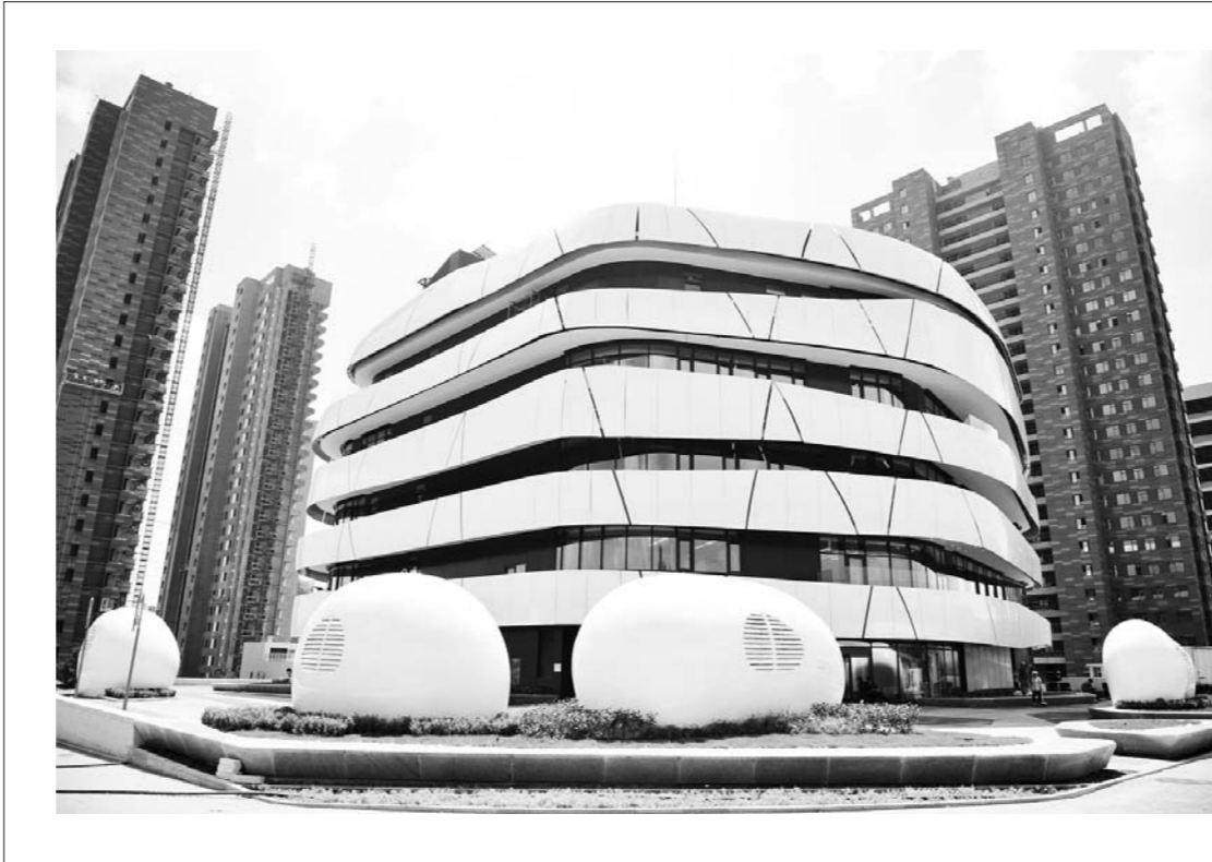
□新华社发 ▲8月11日，亚洲首个高标准被动房示范项目——中德生态园被动房技术体验中心在青岛中德生态园正式投入使用。据介绍，体验中心是一座被动式超低能耗绿色建筑技术研发、体验、展览展示等多功能于一体的综合性建筑体，项目投入使用后，每年可节约27万度电，降低运行费22万元，减少二氧化碳排放275吨。
