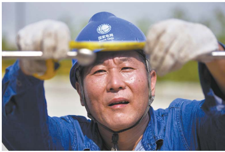
郭方利在烈日下测量、调整零序刀闸的间隙，为接下来的安装工作做着准备。
