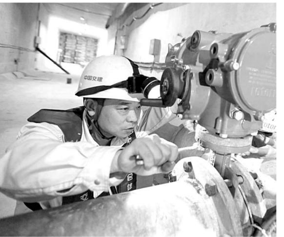
每次沉管安装完成后，压载水系统的电动蝶阀和截止阀都要从沉管里拆卸下来送回牛头岛，经过维修、检测后再次使用。虽然已有了电动打磨设备，但管延安还是习惯自己动手打磨。他在研磨板上铺开耐水砂纸，倒上研
