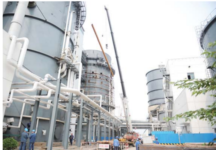
△超低排放改造工地
