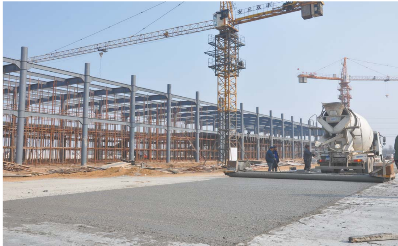
正在建设中的浩宇能源项目。
